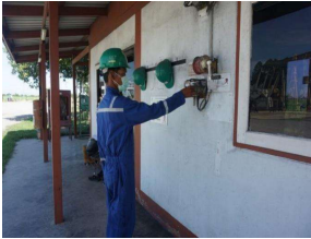
ภาพแสดงการหมุนสัญญาณแจ้งเหตุฉุกเฉินและการกดปุ่มหยุดฉุกเฉินเพื่อ Shutdown ระบบ
